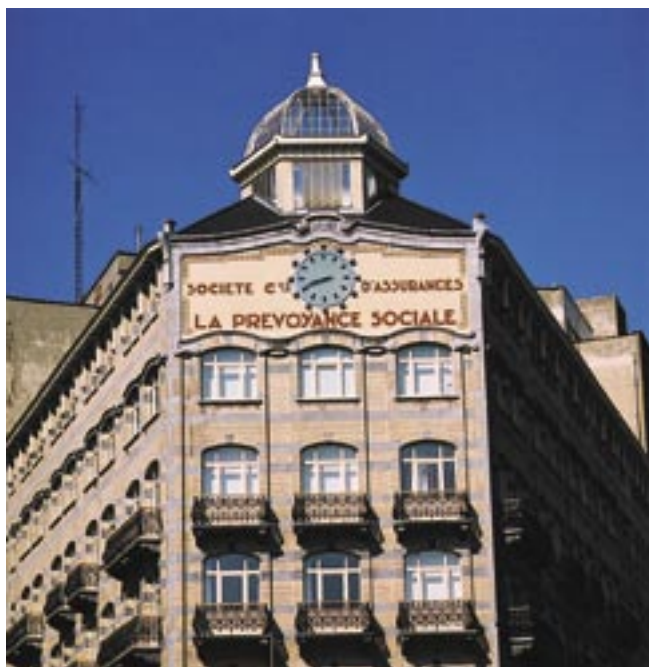
Façade du bâtiment du Square de l'Aviation - Photo Régie des Bâtiments
