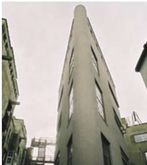
De archieftoren - Foto Regie der Gebouwen
